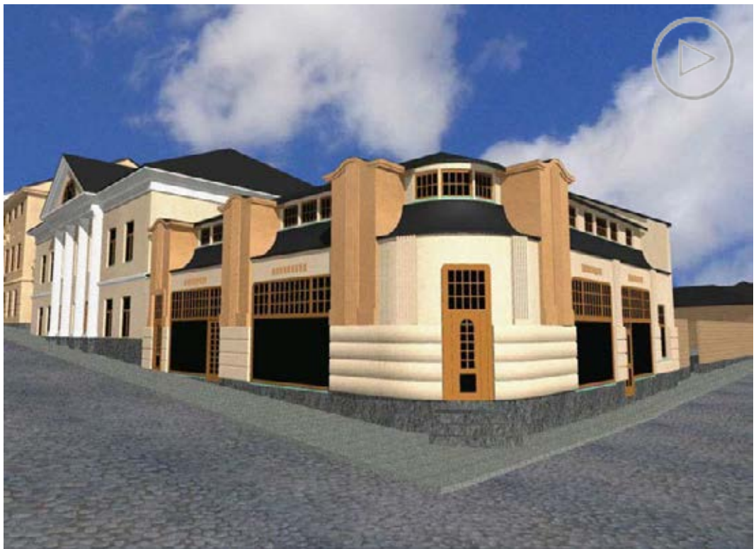
94 Построенное на углу улиц Хармайдenvельестенкату (совр. ул. Краснофлотская) и Линнанкату (ул.Крепостная) доходное здание в стиле модерн было возведено в 1910 году по проекту архитектора Класа Акселя Гюльдена.
