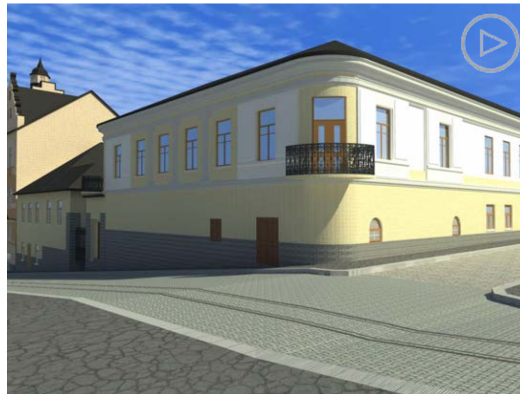
96 Дом консула Ваая, на углу улиц Весипортинкату (ул.Водной Заставы) и Линнанкату. Часть подвальных помещений здания датируется концом XVII века, внешний вид здания – 1795 годом. Длинное строение на участке 18 со стороны улицы Весипортинкату было построено по проекту архитектора Вильгельма фон Карма в 1850 году.
