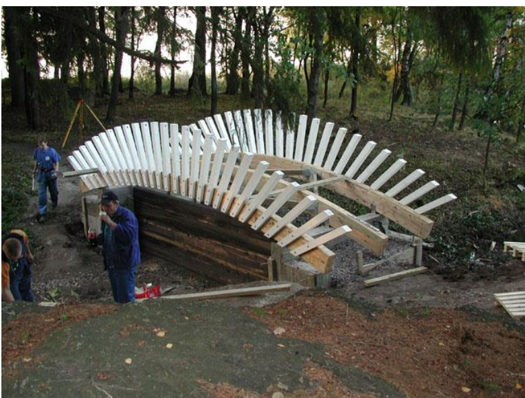
Bild 136. Stolparna har installerats. (TAMK)
