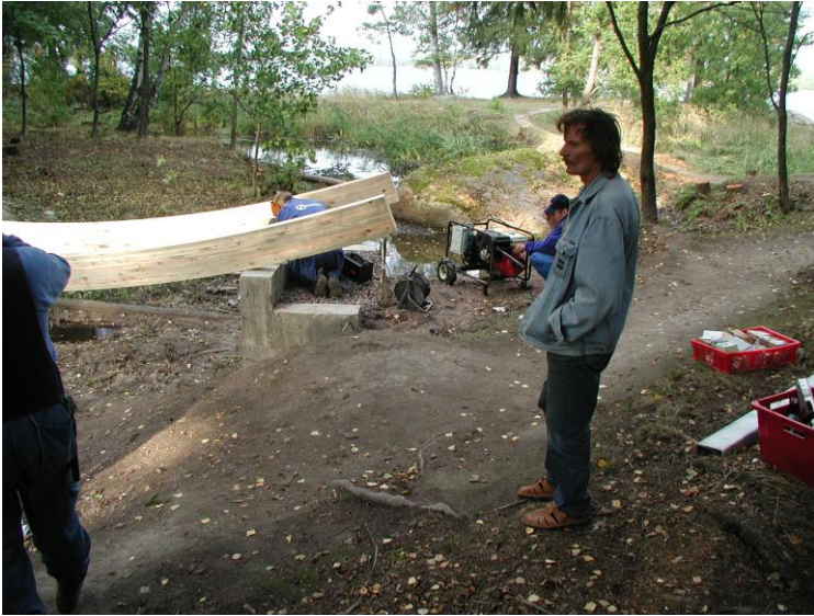
Bild 131. Park Monrepos vicedirektör Igor Zukov följer brobyggnadsarbetet. (TAMK)
