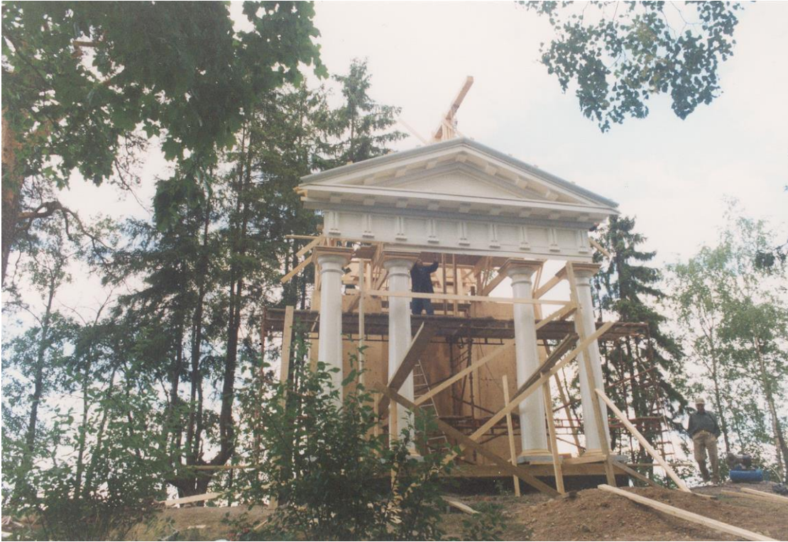
Bild 85. Det främre takskägget måste vinschas på plats med stöd av kroppåsen. (TAMK)
