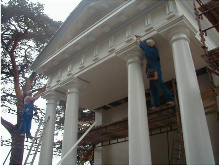
Bild 96. Finslipningsarbete på gång. Pelarna avsmalnar upptill. (TAMK)
