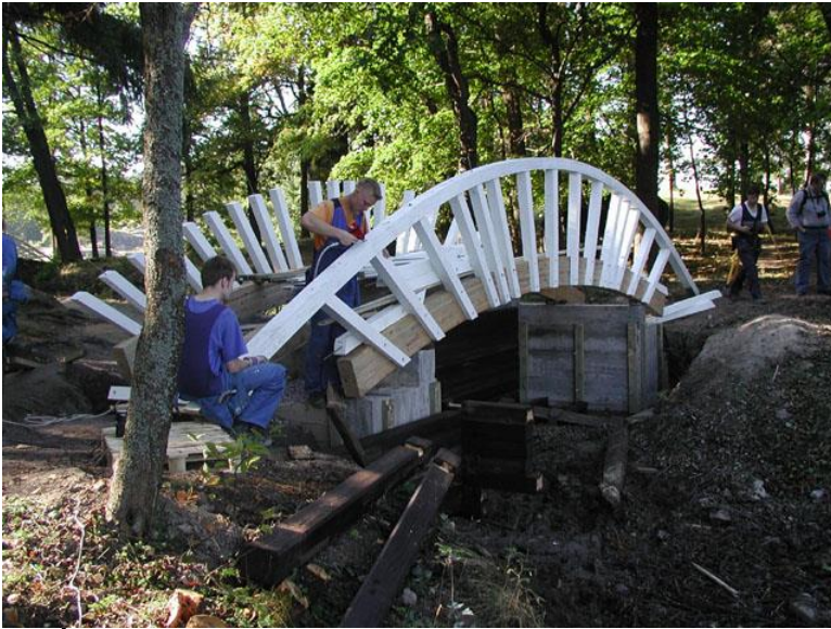
Bild 137. Broräcket, som förberetts i Tammerfors, installeras. (TAMK)
