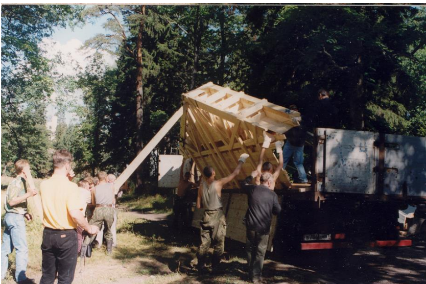
Bild 73. Taksågselementet måste avlastas försiktigt och allas hjälp behövdes. (TAMK)
