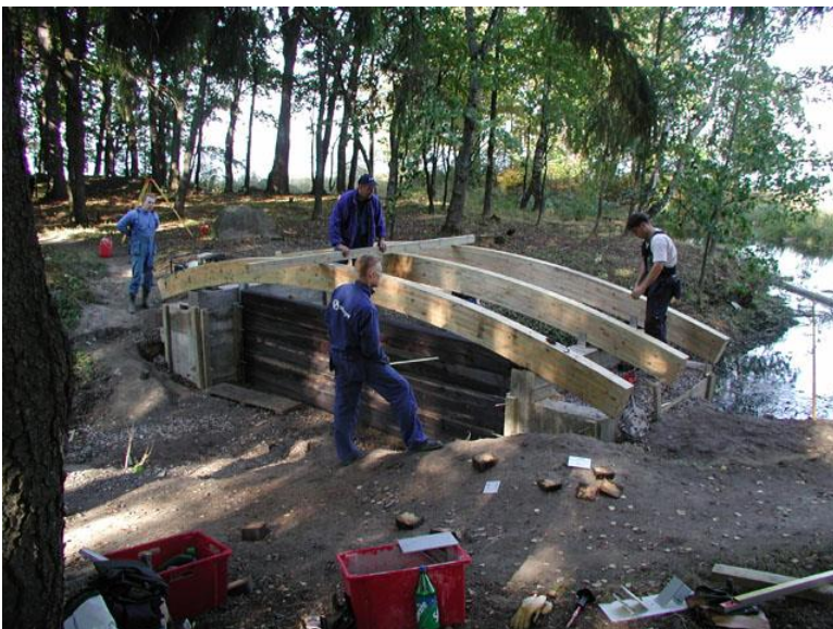
Bild 133. Kontrollmätning av de välvda balkarna i limträ. (TAMK)
