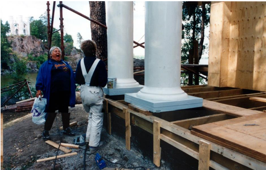
Bild 82. Ira Lankinen kontrollerar arbetsplatsen. (JL)
