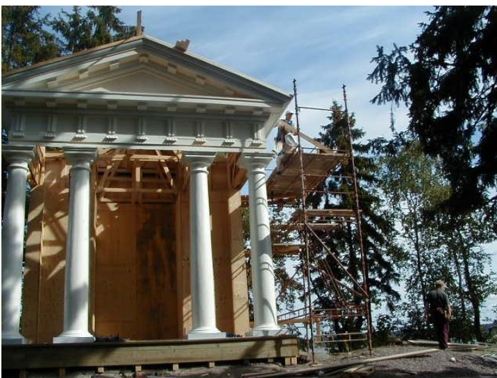
Bild 95. Utsikt mot tempelarbetsplatsen. (TAMK)
