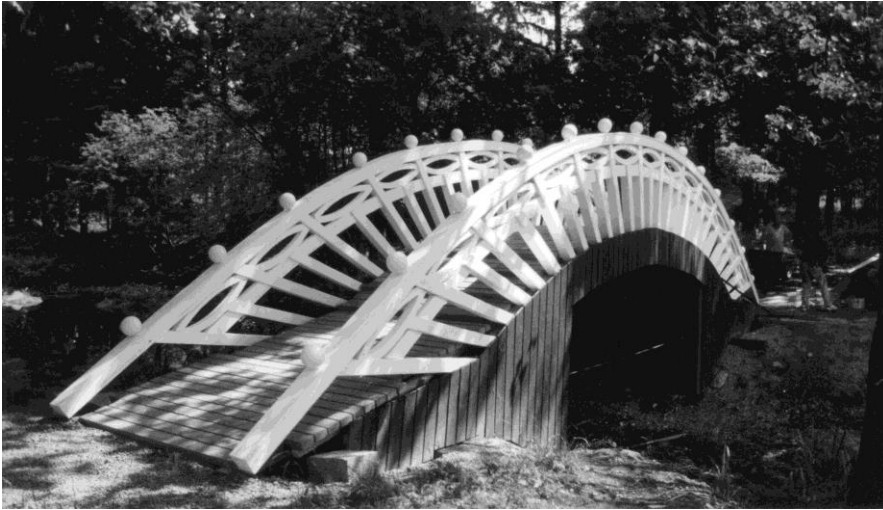
Bild 61. Den färdiga bågbron 1998. (TAMK)
