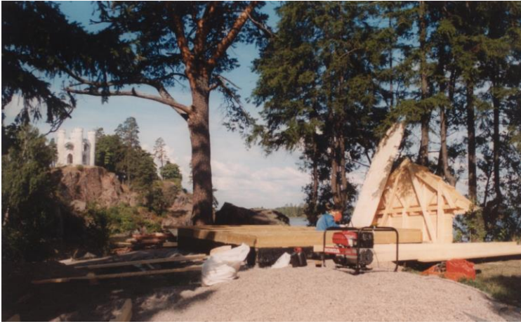
Bild 78. Byggnadsarbetet i skuggan av den gamla tallen började med detsamma. (JL)
