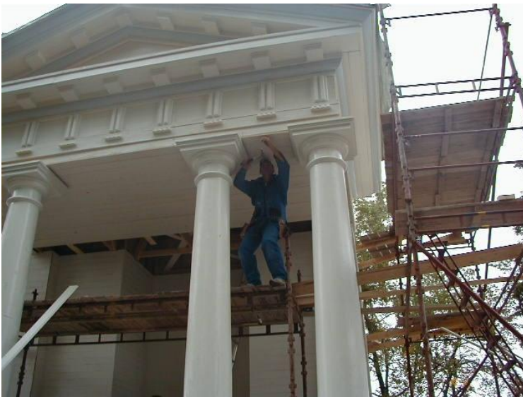
Bild 97. Finslipningsarbete på gång. Arbetsställningarna var hyrda, men ingen hyra måste betalas om ägaren i Tammerfors fick dem alla tillbaka. Alla ställningar återlämnades. (TAMK)
