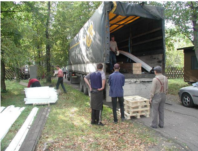
Bild 129. Frakten lossas framför föreningen Pro Monrepos barack, varifrån den transporteras i mindre satser till brons anläggningsställe, som är på en halv kilometers avstånd därifrån. (TAMK)
