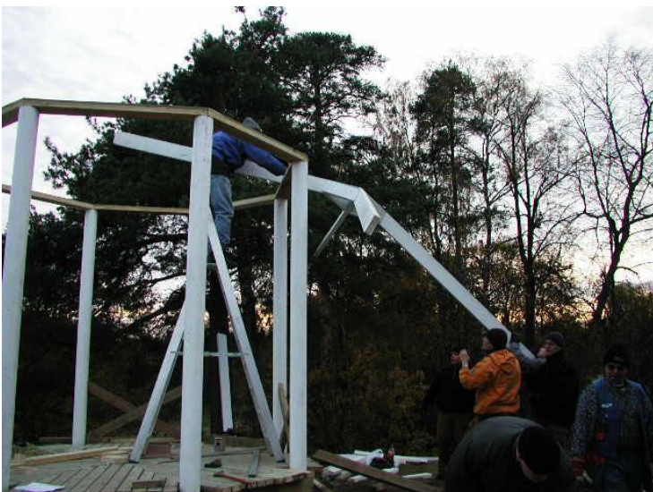
Bild 158. Takets stödbjälkar lyfts upp med gemensam kraft. (TAMK)
