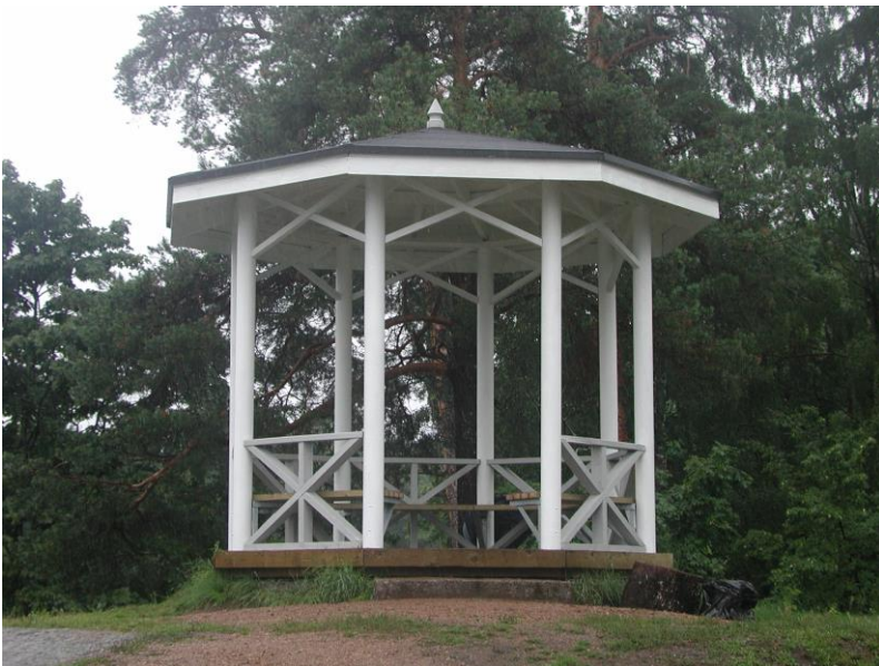
Bild 163. Tétältet står färdigt på våren 2003...(TAMK)
