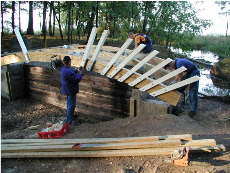
Bild 135. Bröstolparna som förberetts i Tammerfors kunde snabbt installeras exakt på plats. (TAMK)
