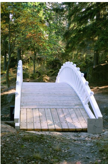
Bild 142. Färdig att användas, gå över bara! Akta de nymålade räckena! (TAMK)
