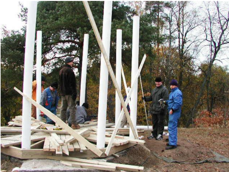
Bild 157. De färdigt målade, rundade stolparna ställdes upprätt. (TAMK)
