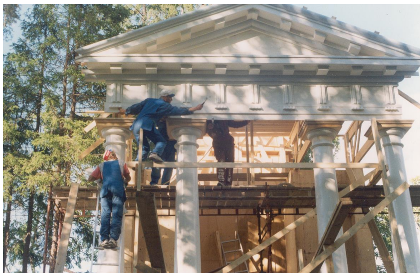
Bild 89. Det främre takskäggelementet är på plats! (TAMK)
