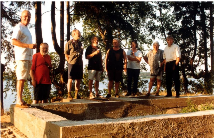
Bild 70. Den ryska samarbetspartnern göt betonggrunden för templet enligt Koreasalos ritningar. Representanter för föreningen Pro Monrepos kontrollerar gjutet 14.7.1999. (JL)
