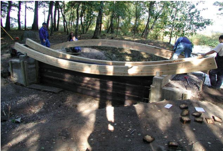
Bild 132. En av balkarna är redan på sin slutliga plats. Två andra i viloställning på marken på det betongstöd, som ryssarna har byggt. (TAMK)
