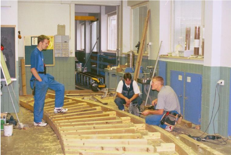
Bild 125. Brobyggarna Jani Turunen, Jarmo Suojanen och Kari Rantanen i byggnadslaboratoriet i TAMK sysselsatta med förberedande arbeten på broräcken. (TAMK)
