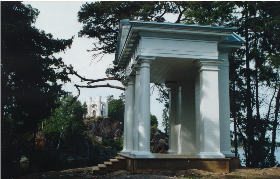
Bild 100. Neptunus tempel stod färdigt 12.9., då Juha Lankinen kontrollerade arbetet. Fyra brudpar köade också samtidigt till stället. Byggarbetet i Monrepos tog endast ett par veckor. Ludwigsburg i bakgrunden. (JL)
