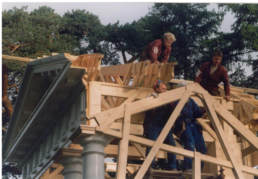
Bild 88. Det korta gallret för templets bakvägg kommer som nästa. (TAMK)
