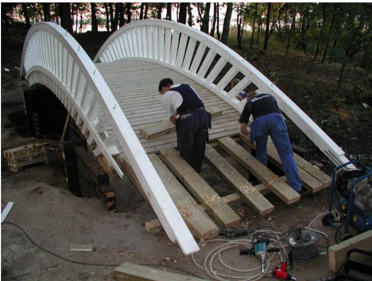
Bild 138. Broplattans skarv installeras. (TAMK)
