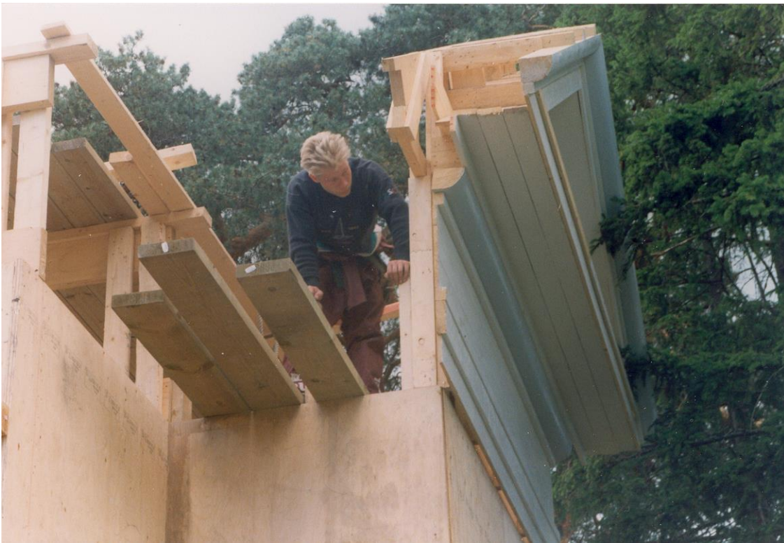
Bild 84. Joni Virtanen fäster bakre takskägget. (TAMK)
