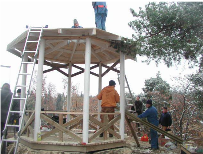
Bild 160. Takets brädfodring är snart färdigt. (TAMK)
