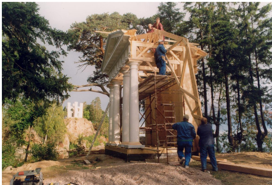
Bild 87. Takgallret på väg till sin slutliga plats på templets tak. (TAMK)
