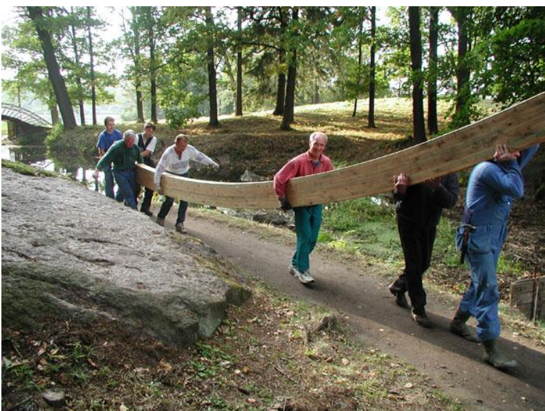
Bild 130. De välvda balkarna bars den sista sträckan. (TAMK)
