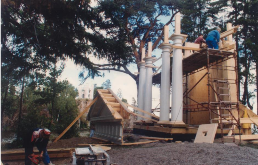
Bild 81. Arbetet med templet är igång 24.8.1999. Pelarna har ställts på plats. (JL)
