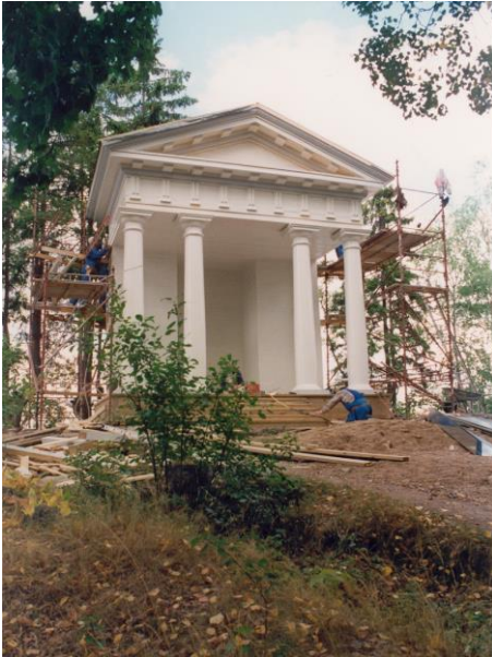
Bild 99. Byggnadsarbetena på slutrakan. (TAMK)
