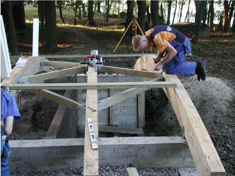
Bild 134. Balkarna spänns in så att de inte sviktat eller svaijar. (TAMK)
