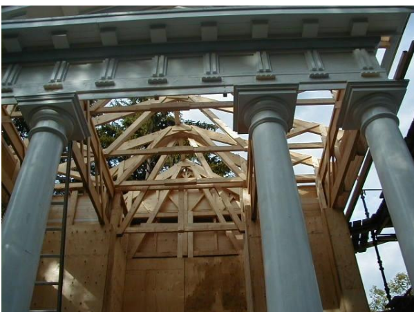
Bild 92. På bilden syns Koreasalos genialiskt planerade takkonstruktion. Balkar från pelarna i form av trägaller mot den bärande bakväggen. Utanpå balkarna takgaller i motsatt riktning. (TAMK)
