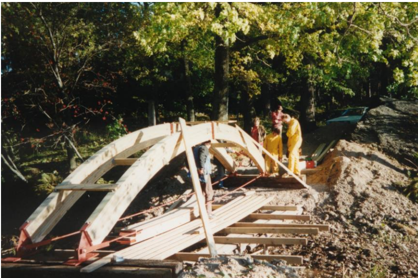
Bild 59. Bågbalkarna provas. (TAMK)
